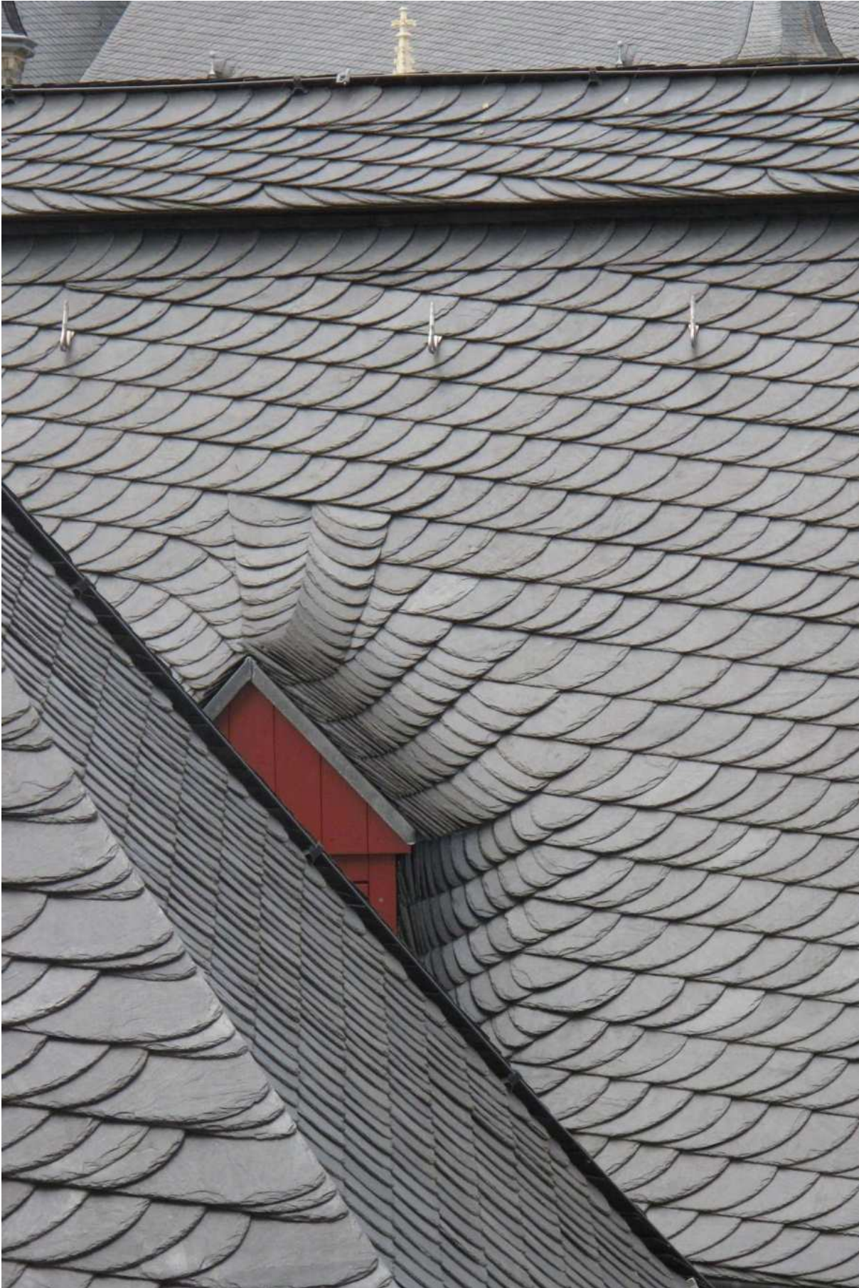
Das Schieferdach des Aachener Kaiserdoms, Krings Bedachungen GmbH, Baesweiler
